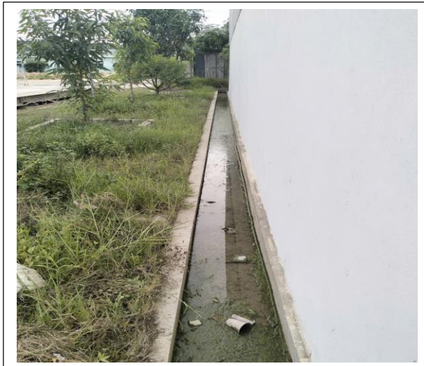
Mương thoát nước mưa
